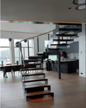
Stíllinn innanhúss er líka svolítið grófur – einmitt vegna þess að þarna var áður verbúð. Það var til dæmis lögð áhersla á að burðarvirkið yrði sýnilegt; stálbitar halda uppi milligólfinu og það eru stálsúlur inni í húsunum. Þá eru stigarnir úr stáli.
